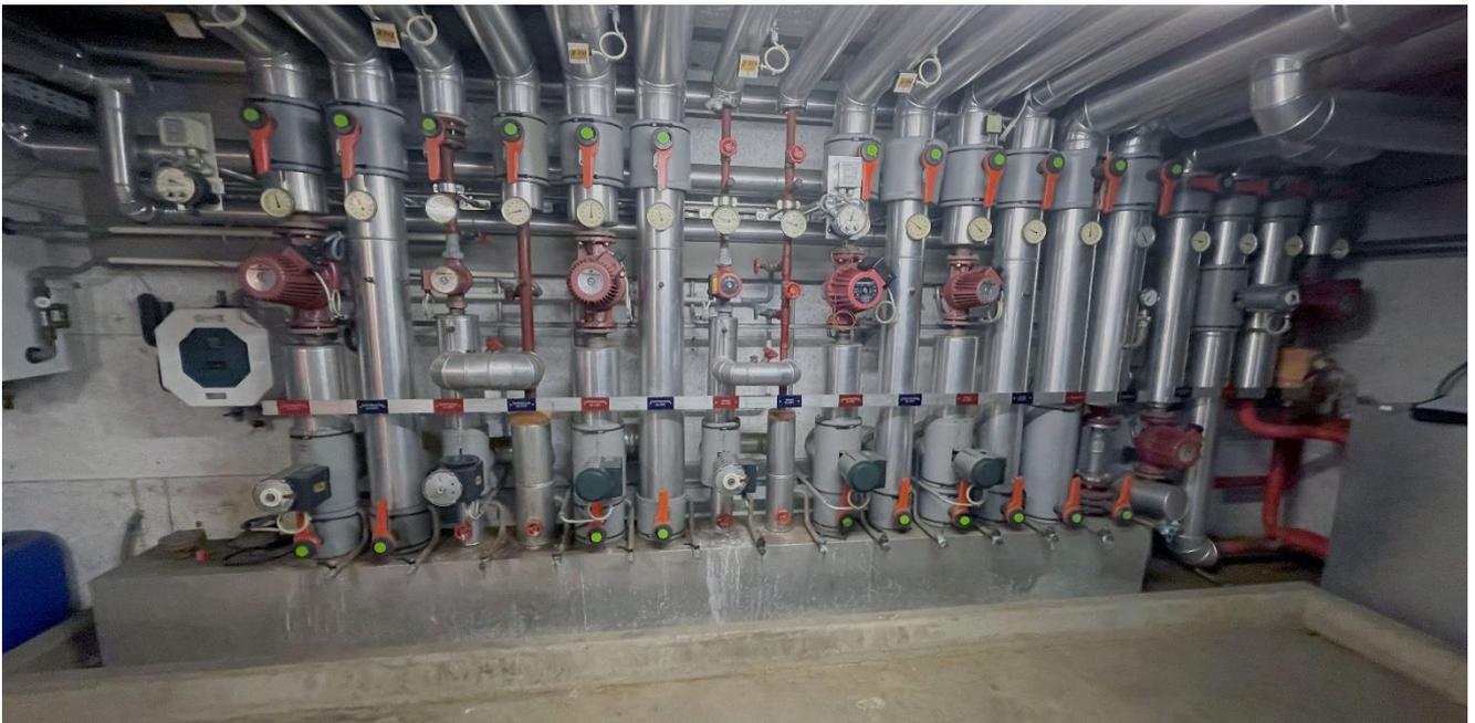
Die Absperrungen konnten belassen werden und der Verteiler wurde auf die Gegebenheiten angepasst. Geliefert fix fertig isoliert, verdrahtet und inkl. Regelung.
